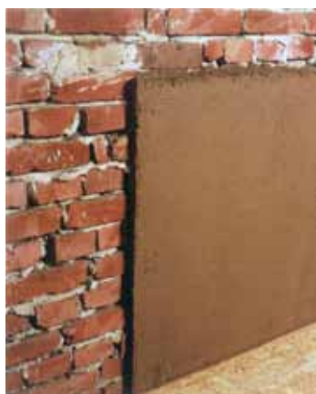
Ausgleichsschicht mit conluto Lehm-Unterputz
